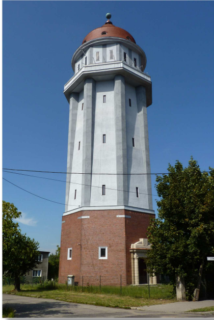
wieża ciśnień w Ostrzeszowie
